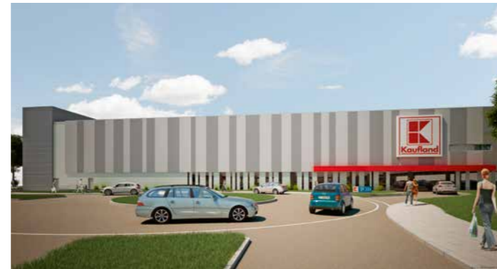
Ansicht Nordost – Einfahrt Tiefgarage
