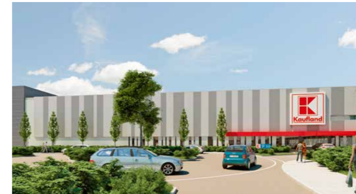
Ansicht Nordost – Einfahrt Tiefgarage
