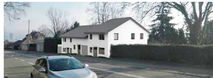
Ansicht Nord – Straßenseite
