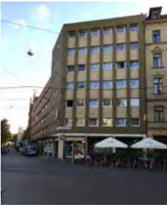
Kaiserstraße, Blick Kronenstraße
