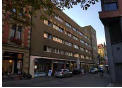
Kronenstraße, Blick Richtung Kaiserstraße
