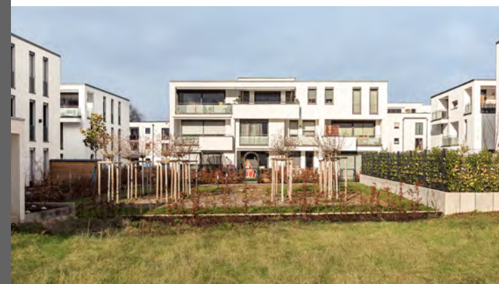
Ansicht Süd, Blick in den Innenhof
