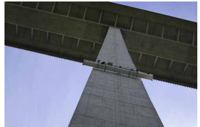
025 Instandsetzung der Betonoberfläche
