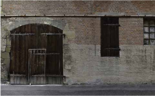
064 Fassadendetail mit Eingang
