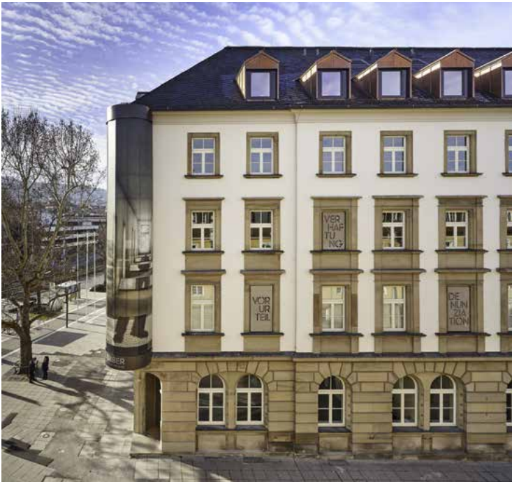
108 Ansicht der nördlichen Fassade mit beschrifteten Steintafeln in Fensteröffnungen
