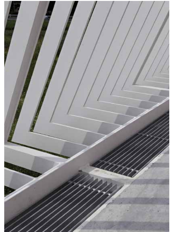
028 Detail der Entwässerung
