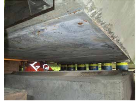
024 Lagerspalt, nachdem das alte Lager ausgebaut ist
