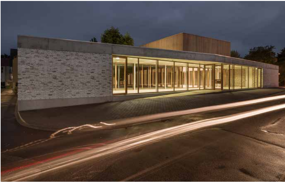
073 Gemeindezentrum von Norden
