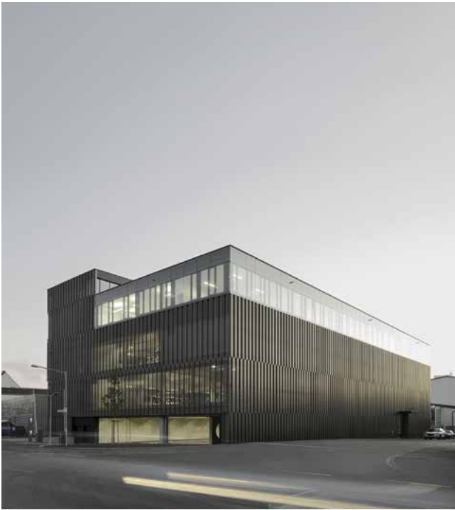
050 Haupteingang – Blick von Nordost
