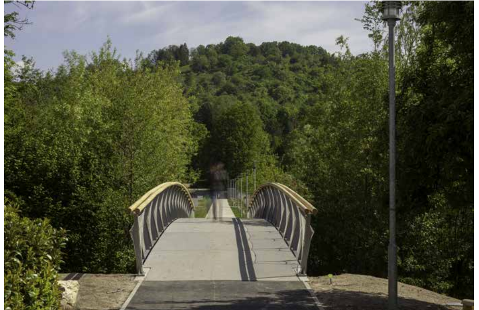
020 Die Brücke über den Urbach komplettiert das öffentliche Wegenetz
