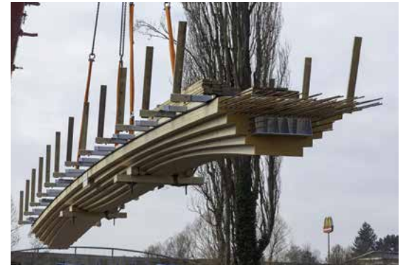
021 Montage des vorgefertigten Brückenkörpers
