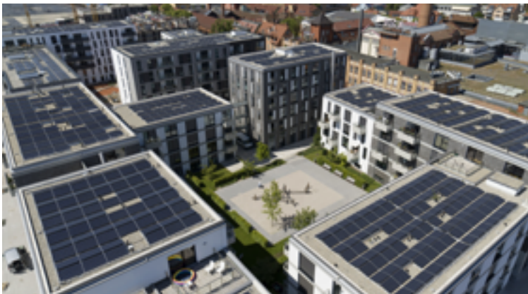
Forum 1 – Neue Quartiere: Esslingen am Neckar, Klimaquartier Neue Weststadt, Blick auf Gebäudegruppe, Dachflächen mit Vollsolarisierung
