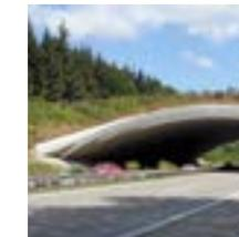
Die Grünbrücke wurde als Querungshilfe für Wildtiere und zum Erhalt gefährdeter einheimischer Arten errichtet. Der prägnante Gewölbebogen mit einer großen Spannweite ermöglicht eine weite und helle Durchfahrtsöffnung. Aufgrund des hohen Vorfertigungsgrads konnte das Bauwerk unter geringer Verkehrsbeeinträchtigung umgesetzt werden.
