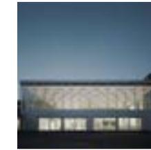
Das heterogene Schulareal wurde um einen zentralen Treffpunkt ergänzt. Der neue Baukörper verbindet zwei bestehende Gebäude. Die Architektur des Neubaus wird durch das Tragwerk mit seinen prägnanten Vertiefungen bestimmt, die der Baumassenreduktion und der Belichtung dienen. Auf abgehängte Decken und Wandverkleidungen wird verzichtet.
