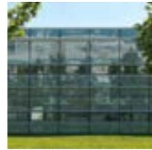
Die Stahlstützen der filigranen Fassadenkonstruktion sind sowohl Haupttragwerk des Neubaus, als auch Träger der Glasfassade. Die Grundrisskonzeption wurde aus den funktionalen Anforderungen der Nutzer abgeleitet. Zur Beheizung des Gebäudes wird die Abwärme des Rechners genutzt.
