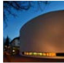
Der zweiteilige Kirchenneubau ersetzt ein ehemaliges größeres Kirchengebäude. Die ovale, aus wärmedämmendem Leichtbeton gegossene Bauform des neuen Hauptgebäudes tritt zum Straßenraum in Erscheinung. Das Nebengebäude mit Mehrzweckräumen ist dagegen bewusst unauffällig und funktional gestaltet.
