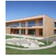
Der Holzbau im Passivhausstandard hat eine funktionale Grundrisskonzeption. Die Holzoberflächen sind innen und außen unbehandelt, die vorgefertigten Wandelemente klebstofffrei mit Holzdübeln verbunden. Verwendet wurden heimische Hölzer.
