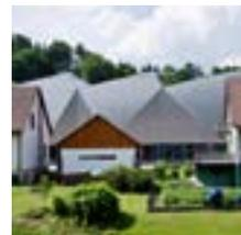
Die Produktionshalle ist der Auftakt für eine städtebauliche Neuordnung am traditionellen Unternehmensstandort. Die Stahlfachwerkkonstruktion mit hohen Spannweiten umfasst ein im ländlichen Kontext verhältnismäßig großes Bauvolumen, das durch gegliederte Aluminiumfassadenelemente optisch in kleinere Einheiten unterteilt wird.
