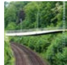
In einem Waldgebiet überbrückt die 27 Meter lange Fuß- und Radwegbrücke eine S-Bahnstrecke. Die geschwungene, nach dem Prinzip des Einfeldträgers konzipierte Form des Stegs ergibt sich aus dem Höhenunterschied der beiden Auflager. Gestalterische und sicherheitstechnisch notwendige Elemente wurden besonders aufeinander abgestimmt.
