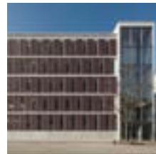
Das Parkhaus wurde gut in den innerstädtischen Kontext integriert. Aufgrund seiner Maße und seiner auffällig gestalteten Fassade bildet es einen markanten Auftakt zum Stadtzentrum. Der Stahlbetonkonstruktion ist eine offene Mauerwerkfassade vorgehängt, die Blickbezüge aus dem hellen Innenraum in das städtische Umfeld ermöglicht.
